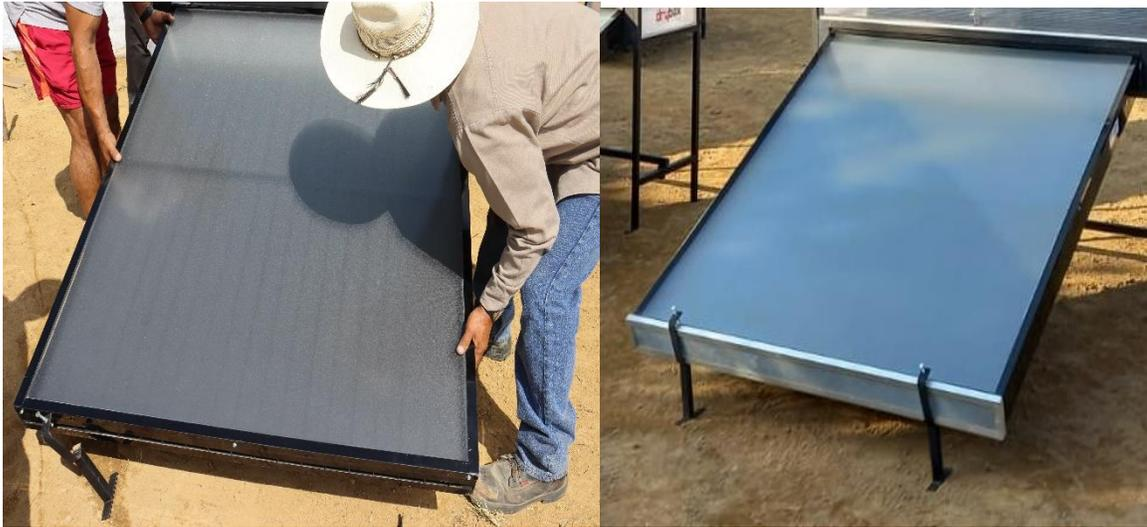
Nota: En la parte izquierda se puede apreciar la instalación del colector solar con la cámara de secado, mientras que en la parte derecha se aprecia el colector instalado y el elemento filtrante el cual es sujetado por las dos bases que se encuentran en la entrada del colector. **Fuente:** Instituto de Energías de la UNAM, Hueyapan Morelos, Propia (2022).
