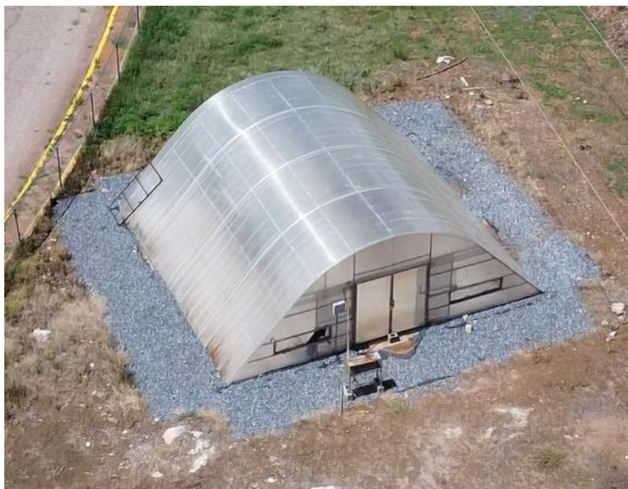
Figure 4 Secador solar directo tipo invernadero con capacidad hasta 1 tonelada
