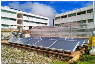
Figura 4 a). Instalación y arreglo de los paneles del sistema solar fotovoltaico; 4 b) Instalación del sistema de almacenamiento térmico (termotanque-resistencia-bomba).
