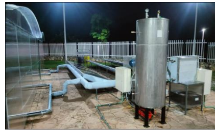
Figura 4 a). Instalación y arreglo de los paneles del sistema solar fotovoltaico; 4 b) Instalación del sistema de almacenamiento térmico (termotanque-resistencia-bomba).
