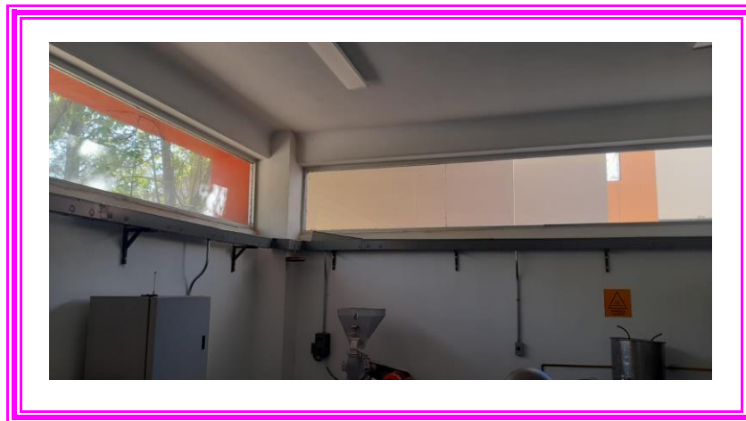
Figura 7. Ventilación del área de elaboración de los productos en la Planta Piloto de Alimentos
